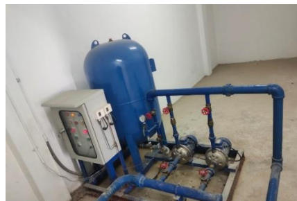
รูปที่ 43 booster pump
